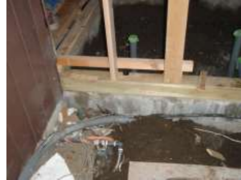
土台、柱交換補修
