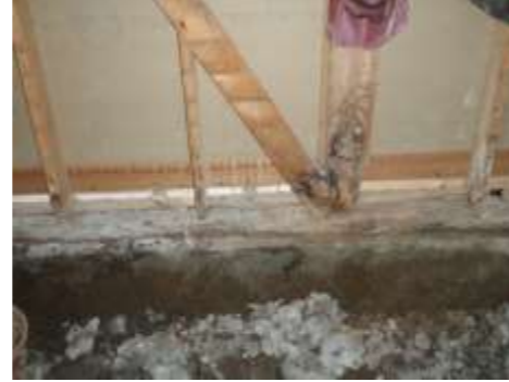
解体(土台、柱腐食状況)
